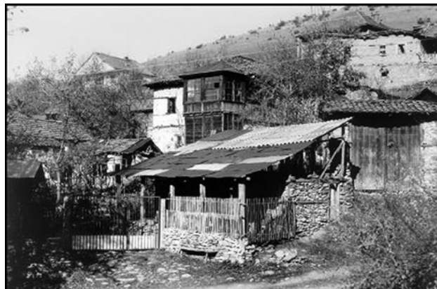
Фото 4 - Фасада од два спротивставени делови, различни елементи, конструкции, материјали, ефекти
